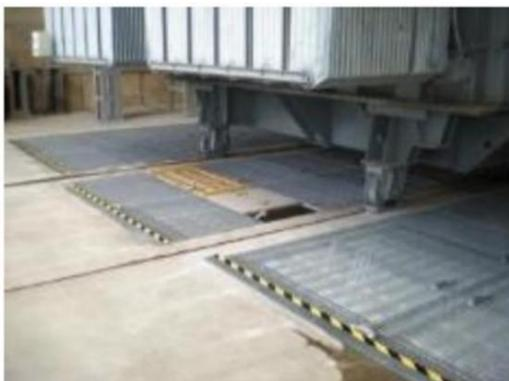
**Figura 76** - Exemplo de poço individual ao redor do transformador
