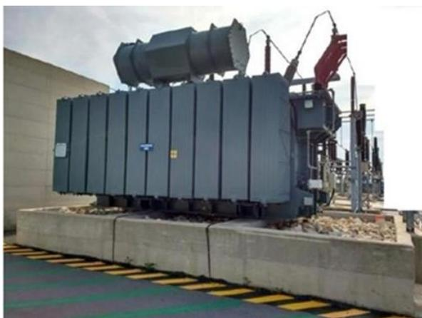
**Figura 41** - Lado MT do transformador de potência
